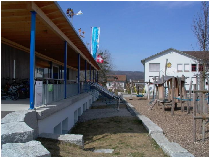
Im Gebäude links, dem Hub Blau, befindet sich unter anderem ein Aussenschulzimmer.
